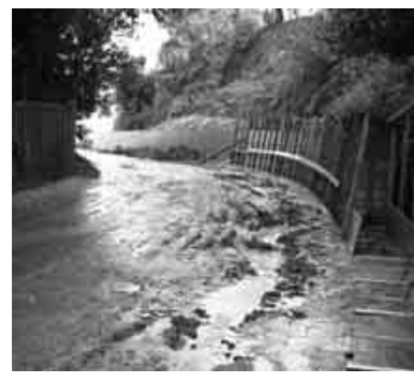
GLI INTERVENTI DI CONSOLIDAMENTO DELL'ARTERIA
